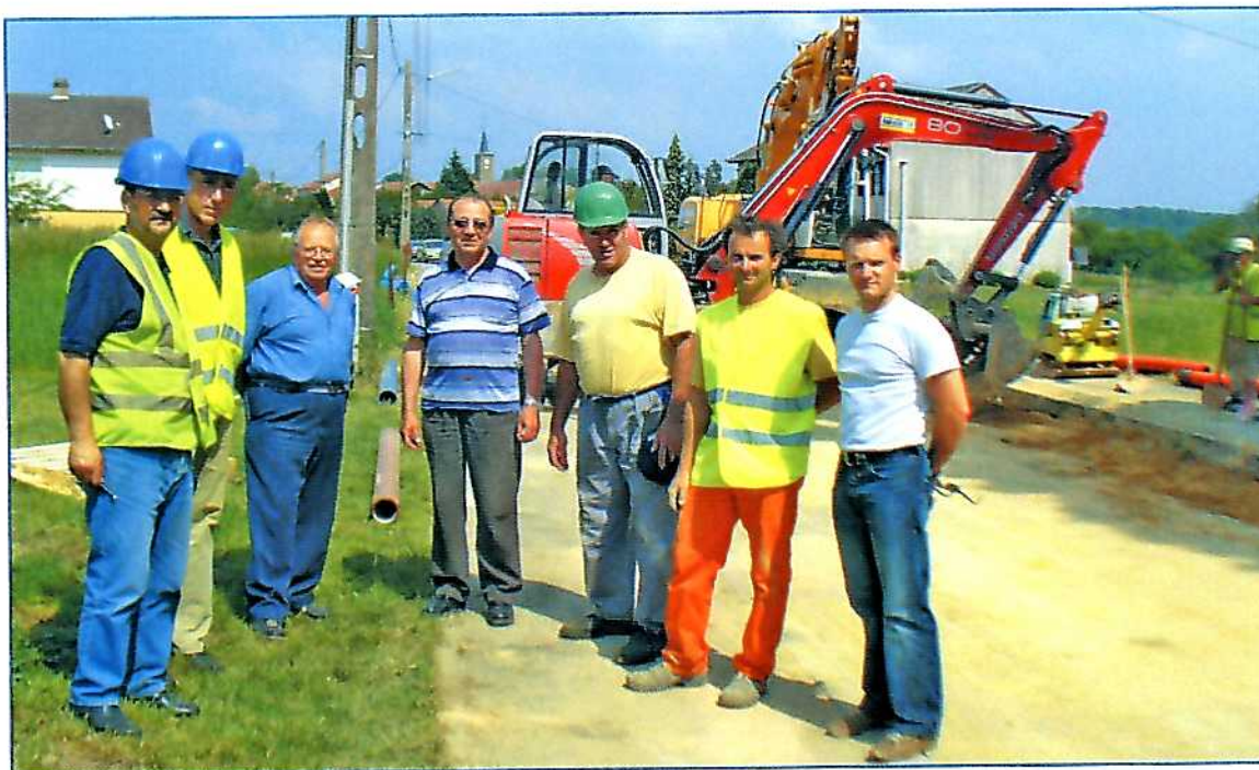
Réunion de chantier rue de la Nied
