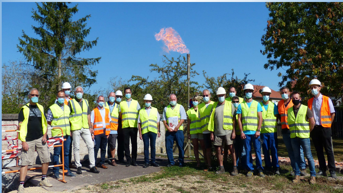
Mise en gaz du réseau principal de distribution
