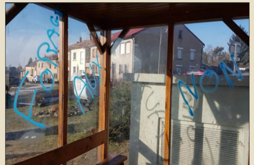
La dégradation aurait été faite dans la nuit de samedi à dimanche. Photo RL
