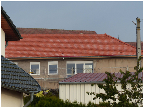
Bâtiment hors eau et hors air
