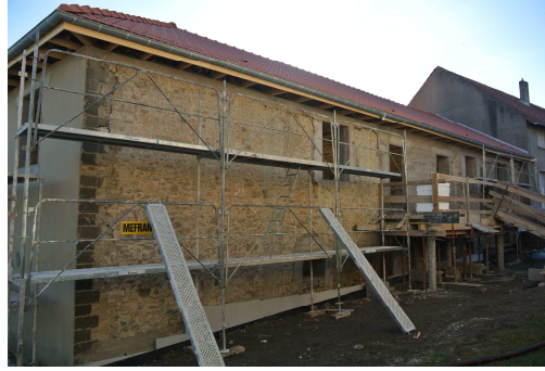
Crépissage des murs extérieurs
