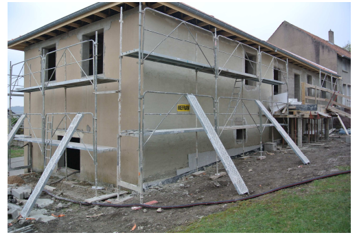
Crépissage des murs extérieurs
