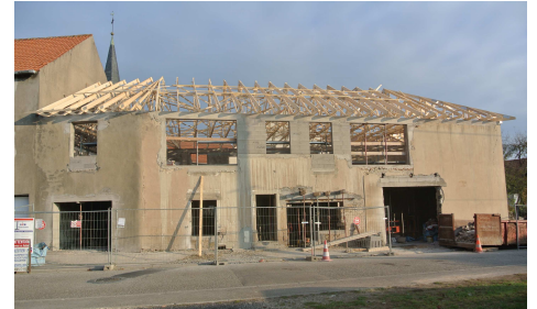
Montage de la charpente
