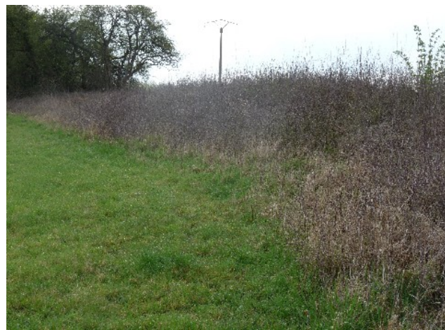
Digue sud-est dont le talus est colonisé par des friches (©ESOPE)
