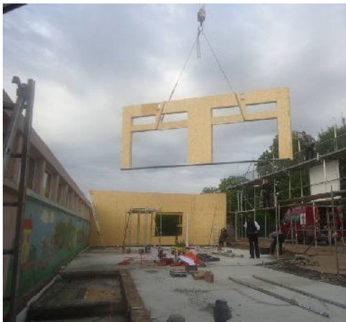
Montage des panneaux de la structure bois en une journée
