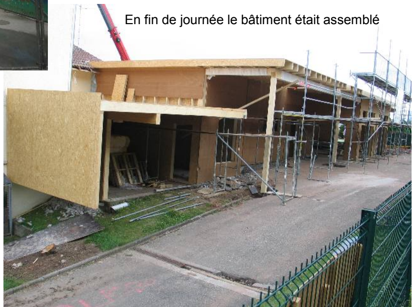
Assemblage des éléments du toit
